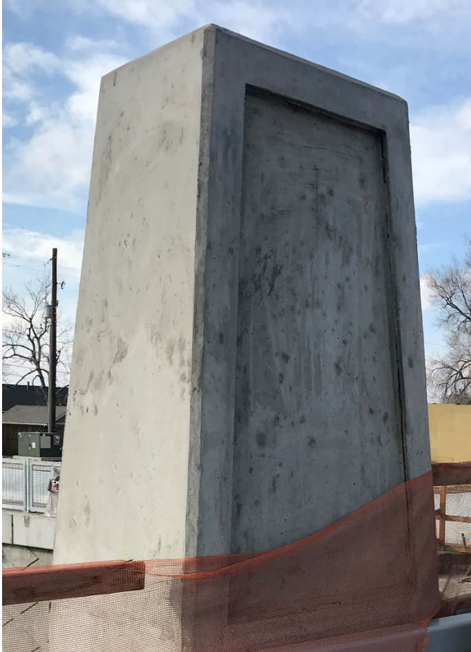
Vista de uno de los 12 monumentos de "gateway" con zona de inclusión para obras de arte en mosaico
