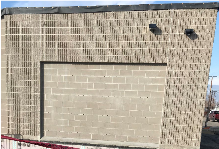
Vista del edificio comunitario con la zona de inserción para las obras de arte en mosaico
